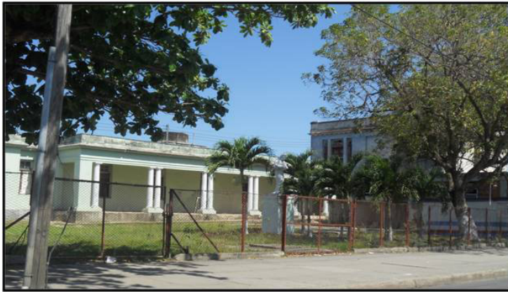
Hospital de Maternidad. Arriba: vista antigua. Abajo: vista actual.
