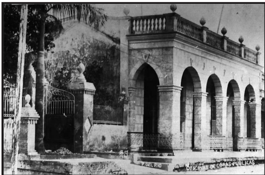
Oficinas de Obras Públicas, que sustituyeron al colegio “Raja Yoga”.
