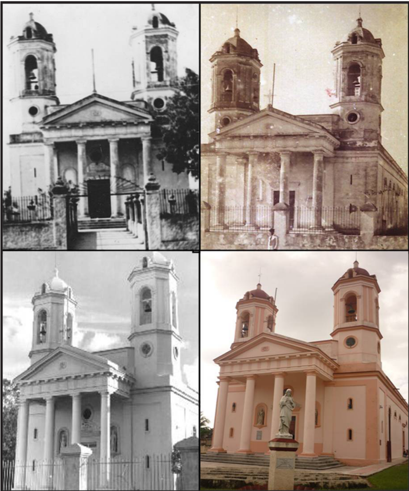
Arriba: Catedral de Pinar del Río en la primera mitad del siglo XX. Debajo: esplendor de la Catedral de San Rosendo en 1956, al terminar el trabajo de restauración y mejora a cargo del obispo Mons. Evelio Díaz Cía (izquierda) y vista actual (derecha).
