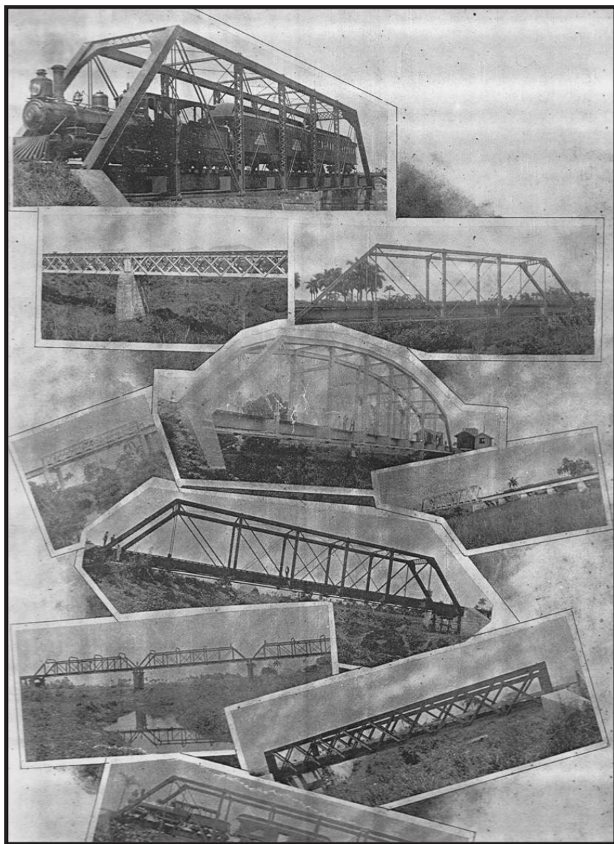
Algunas vistas de los puentes de la línea férrea del oeste, que ponía en comunicación a la capital de la República con la región más occidental.
